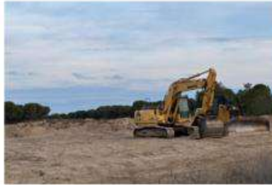
Maquinaria en la construcción de la U de Olmedo.ICAL
