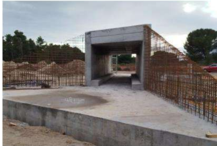
Obra del viaducto de la U de Olmedo en Valladolid.E. M.
