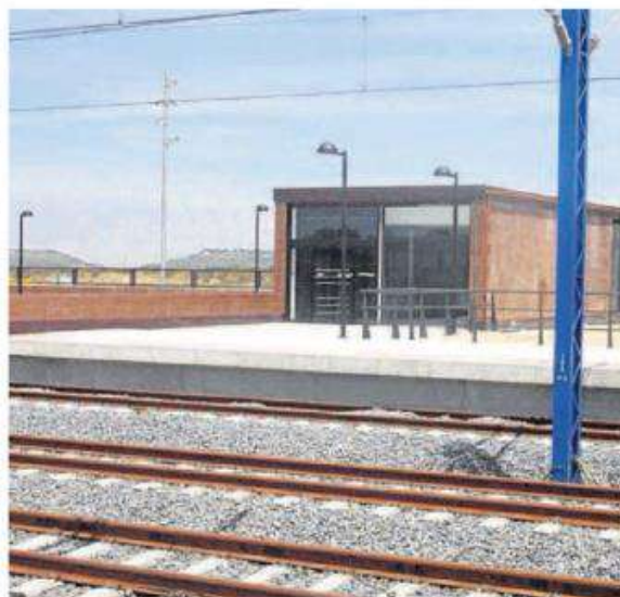
Andenes de la estación de trenes de Olmedo. FRAN JIMÉNEZ
