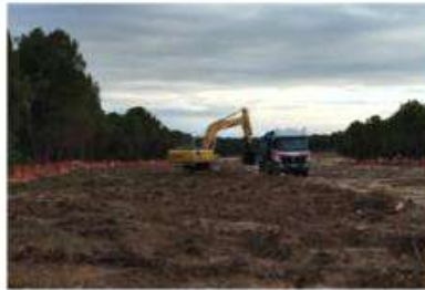
Obra de desbroce en la 'U de Olmedo' de Valladolid.E. M.
